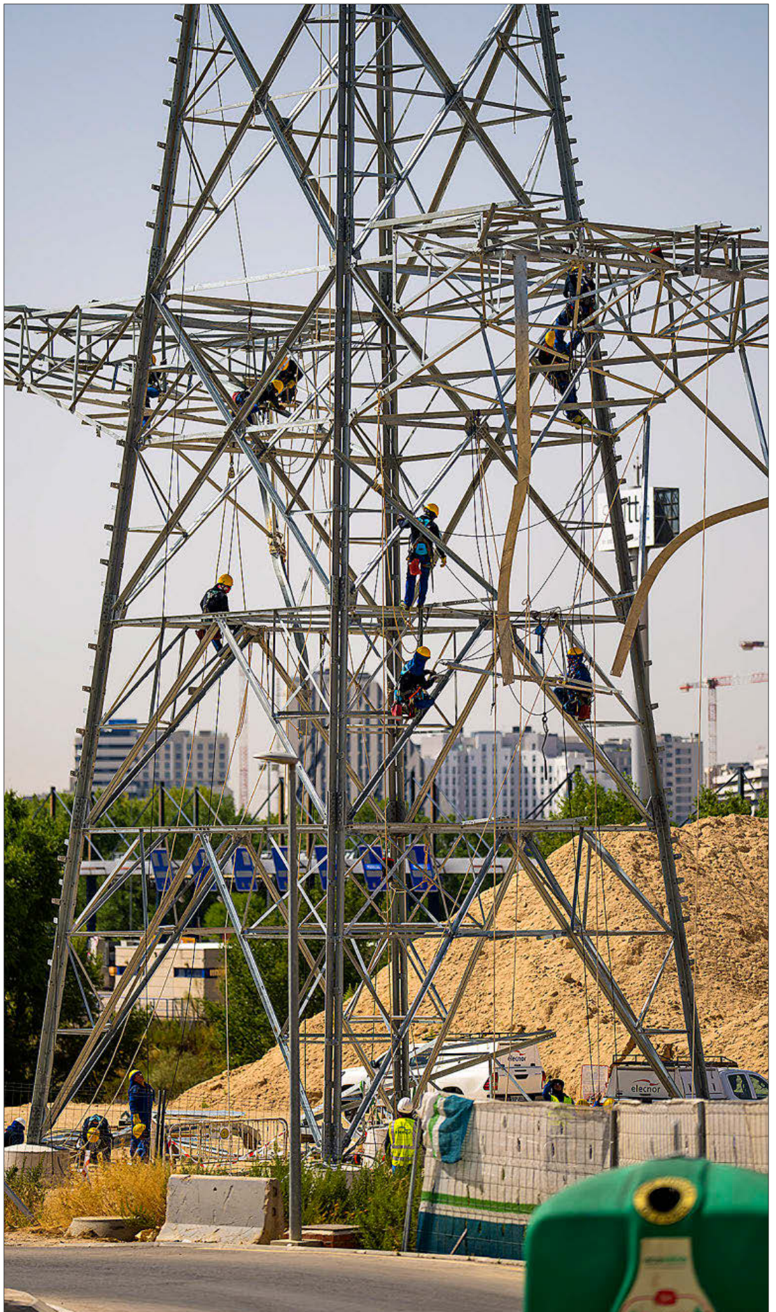
Operarios levantan una torre eléctrica próxima a urbanizaciones de La Moraleja (Alcobendas). ÁNGEL NAVARRETE
